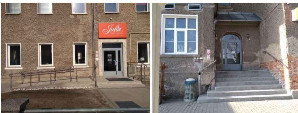
Hlavní vstup a boční vstup (pokladna, kavárna, obchod s barevným sklem)
