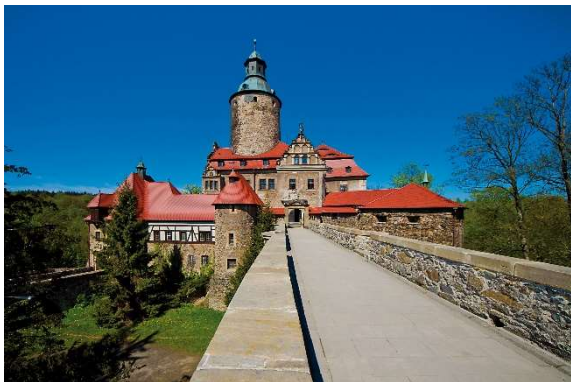
Chodnik prowadzący do wejścia
