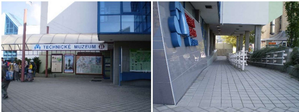
Von links: Fläche vor dem Museumseingang, Auffahrtsrampe auf dem Zugangsweg zum Museum
