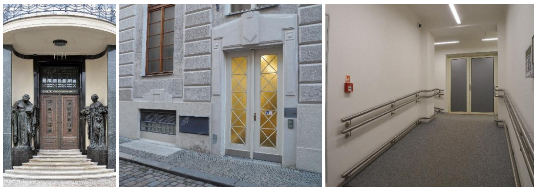
Od lewej strony: Wejście główne, wejście boczne, rampa przy wejściu bocznym
